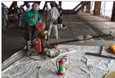
先日、某現場にてガソリンタンクの管理について厳重注意を受けました。道具と一緒にガソリンタンクを置いた場所が時間の経過で日向になり、引火の危険性を現場管理者から指摘されたのです。炎天下に置かれて高温になったガソリンタンクの内部は可燃性ガスの圧力が高まり、タンクを開けた時に一気に噴出して
